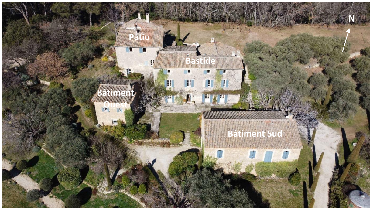
Vue aérienne plongeante sur les bâtiments existants
