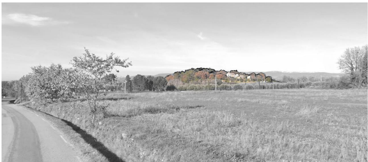
Le site depuis la route d'Oppède-le-Vieux, perception éloignée en venant du Sud - Seul le bâti émerge de la colline boisée
