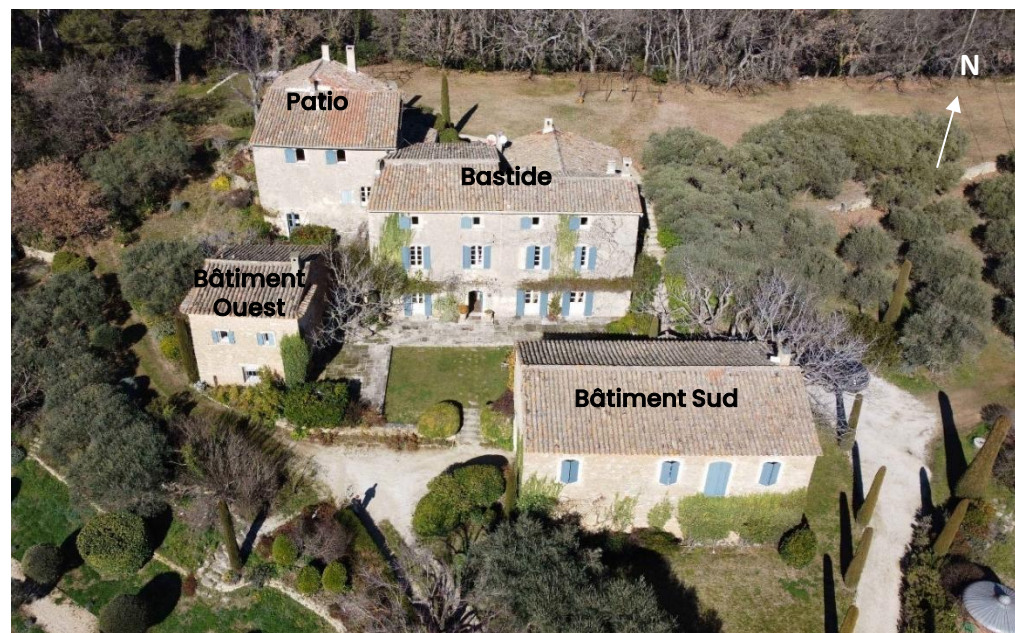
Vue aérienne plongeante sur les bâtiments existants
