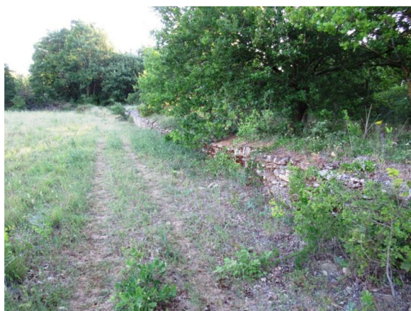
Muret de soutènement à pierre sèche (restanque) présent sur le secteur de projet : un motif agro-paysager à préserver Source : Naturalia
