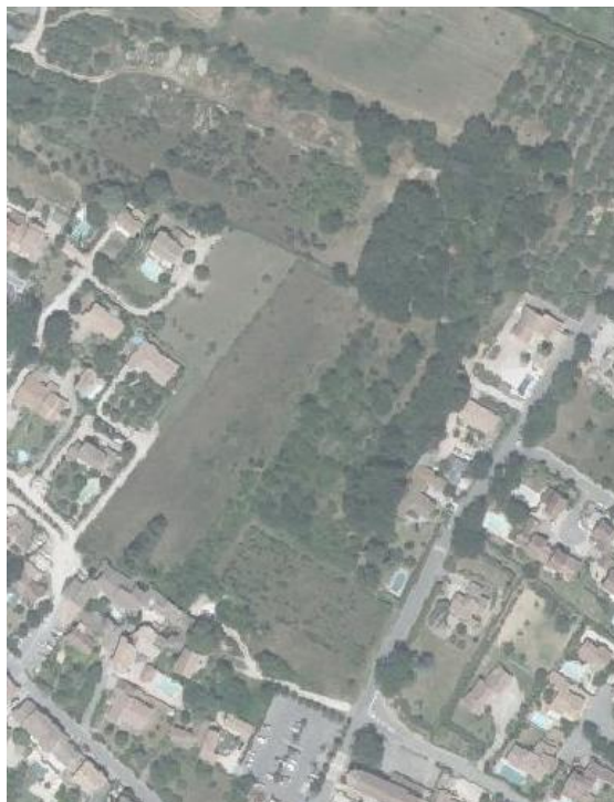
Vue aérienne du secteur de projet en 2025
