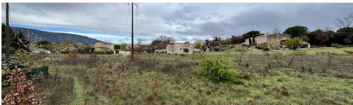
VUE N°11 – Vue axée ouest : tissu résidentiel pavillonnaire en frange du secteur de projet
