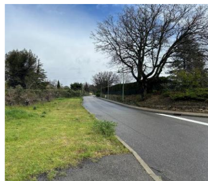
Route de l'Église (après travaux) au niveau du secteur de projet (à gauche)
